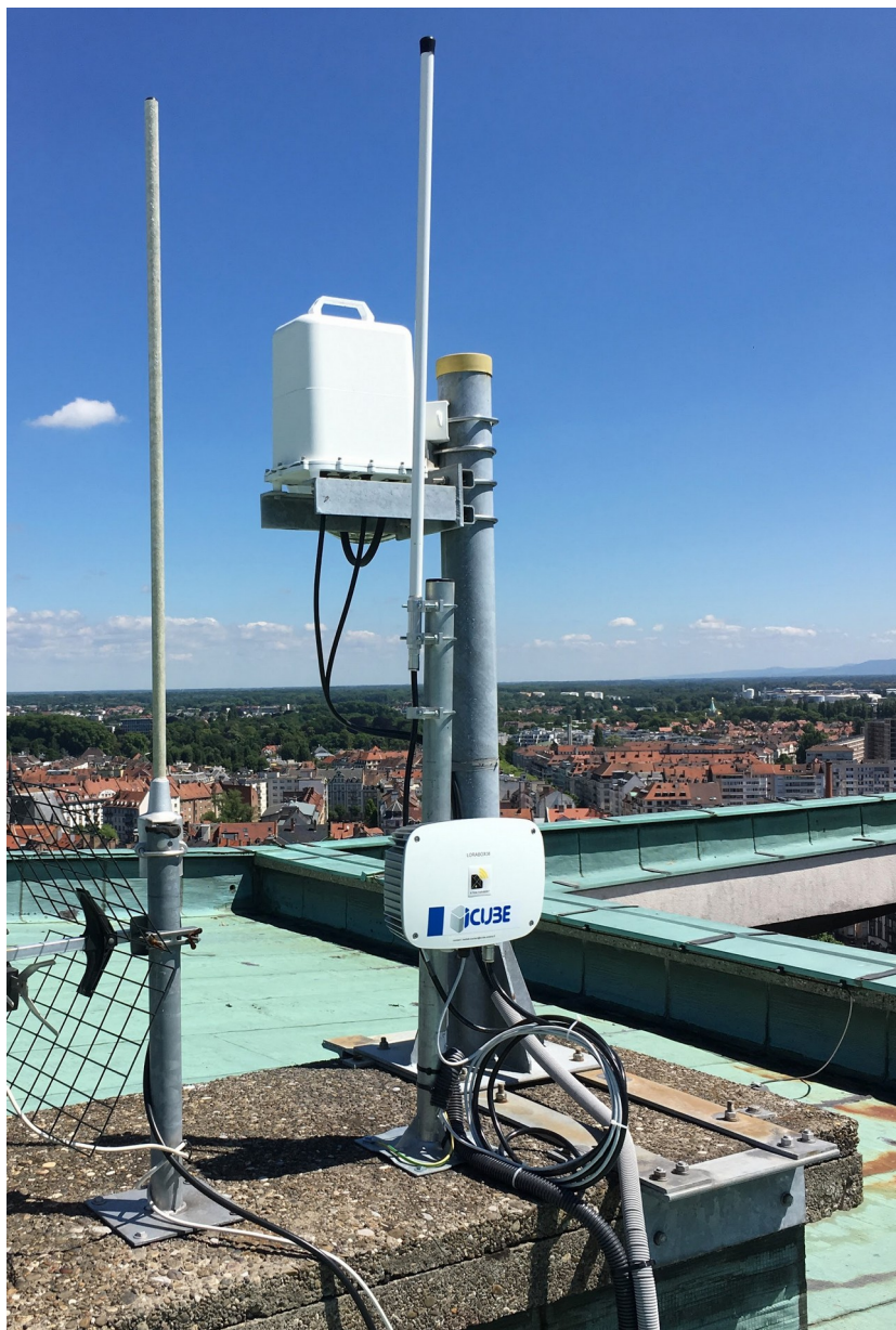
Figure 3 - Exemple de gateway LoRaWAN équipée d'une antenne omnidirectionnelle
